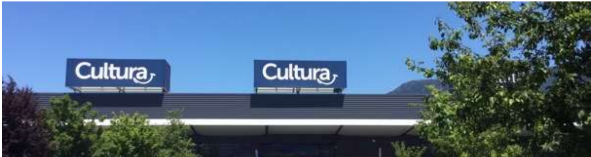
Enseignes sur toiture (non conformes car lettrages pleins), Ville-la-Grand, juin 2019
