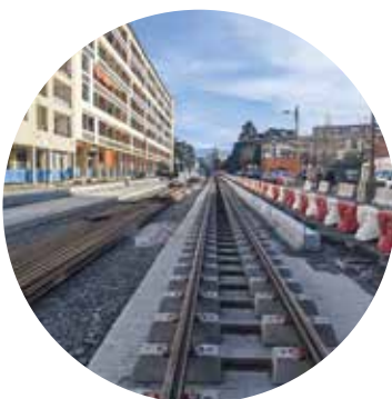
Premiers rails du tramway.
