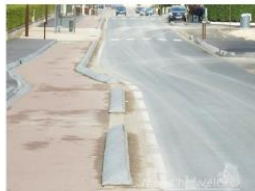
Bordure pierre ou béton type A2
