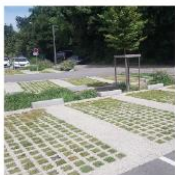
Béton type «viaverde». Béton plein pour place PMR
