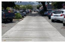
Revetements béton sablé sur les voies de circulation
