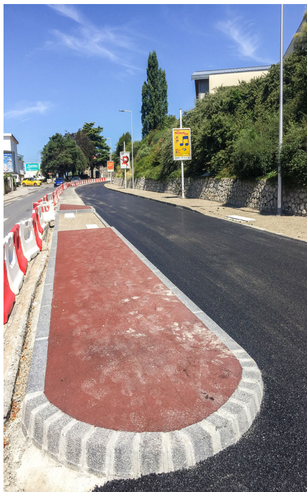
Photo de la route d'Étrembières après la rénovation de la chaussée dans le sens montant - 2020
